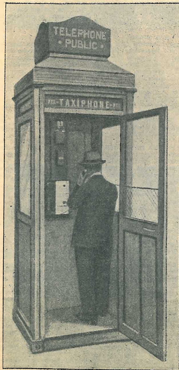
Fig. 1. — Cabina telefonica a telefono ed a pagamento automatico, installata a Parigi a titolo di esperimento.
